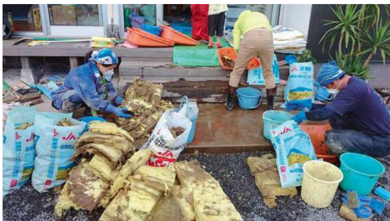
↑ 断熱材の取出し
