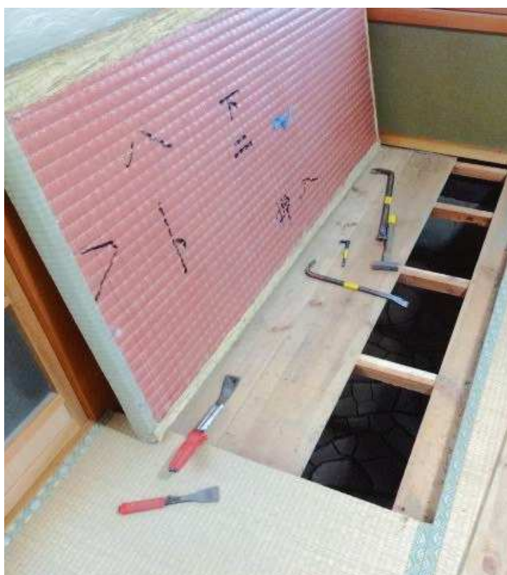
和室の床板をはがす（写真①）
